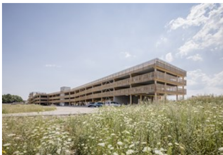
Photo Parking des Bohries - Archi : Jourda Architectes Paris - Photos : 11h45
